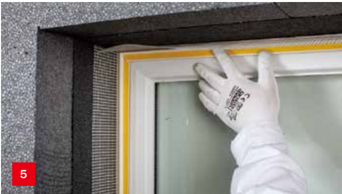
门窗连接线条 安装门窗连接线条，增加窗与墙体之间的密实性和防水性。
