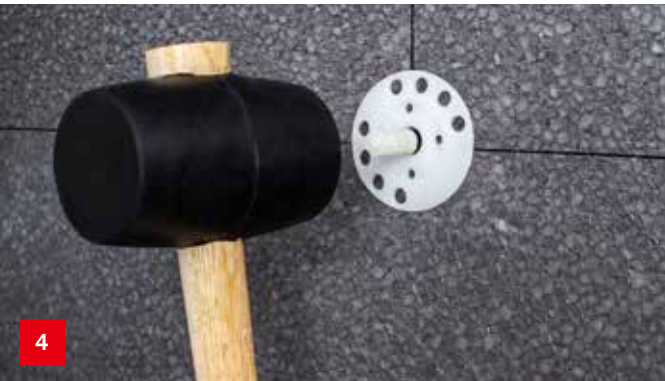
锚固件安装 粘结剂干燥前不能进行锚固。锚盘必须准确设置在保温材料表面并保证平整度。
