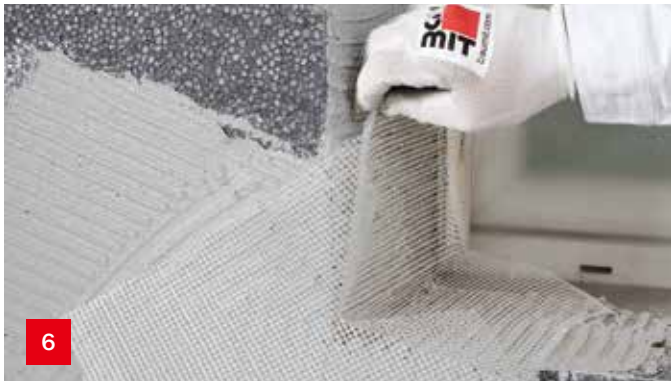
阴角部位的加强处理 窗框四角内侧粘贴一层网格布进行局部加强处理，网格布也必须与大墙面进行搭接处理。
