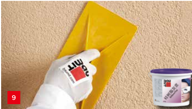
饰面装饰灰浆 首先应施工底涂漆。经搅拌后的砂浆可通过金属抹刀施涂于基墙面。并用塑料打磨板对表面进行打磨以形成最终效果。
