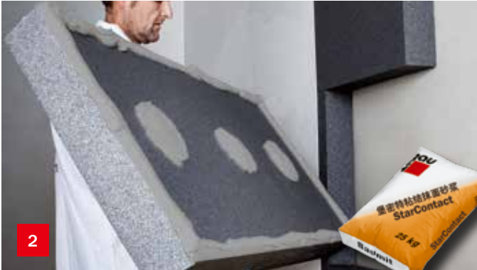
保温板粘贴 保温板安放应做到横平竖直，拼接严密，不应留有间隙。
