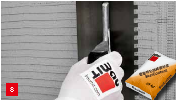
加强层施工 用不锈钢锯齿抹刀进行粘结抹面砂浆的施工，厚度为2-3mm。必须趁砂浆未变干时，将耐碱玻纤网从上到下顺势埋入粘结抹面砂浆，压实无褶皱。耐碱玻纤网格布应上下左右至少搭接10cm，网格布必须嵌入胶浆并保证其处于胶浆的外1/3处。
