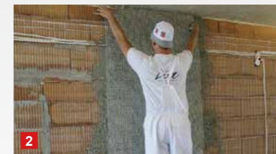
2 必要处压入网格布进行加强处理
