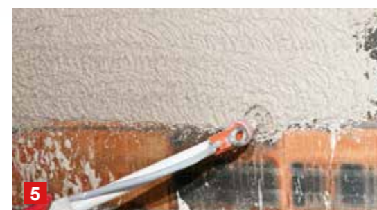
5 用喷涂机进行石膏砂浆喷涂
