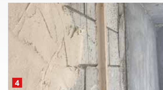
4 用石膏砂浆打点,冲筋
