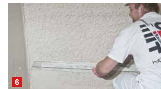
6 对喷涂好的石膏砂浆刮平
